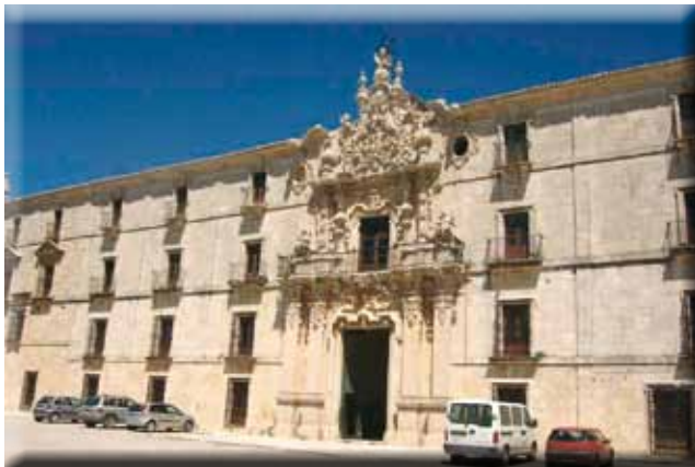
Fachada principal del Monasterio de Uclés
