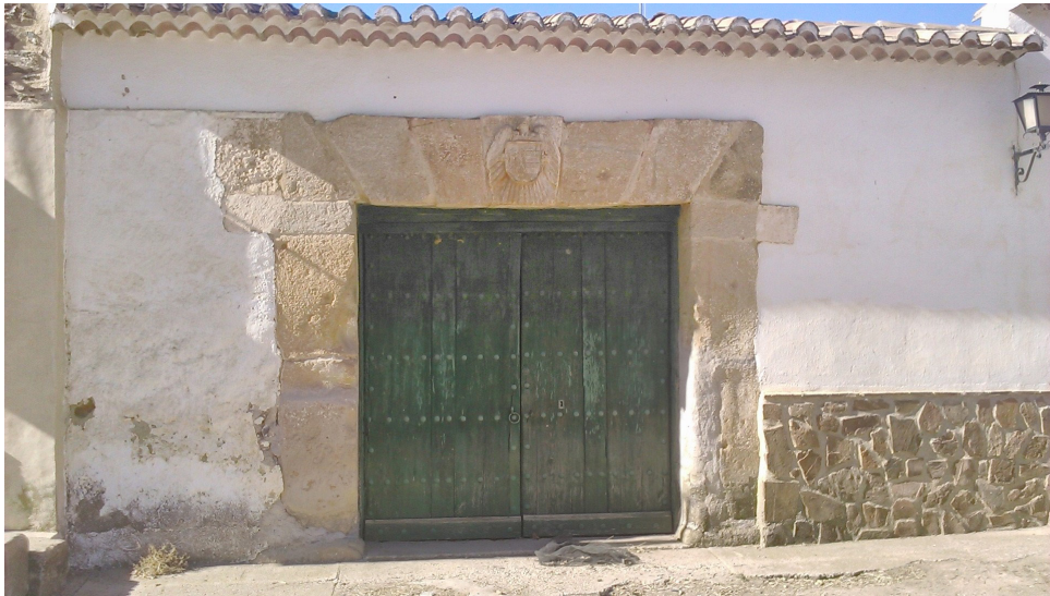
Fig. 6: Portada de entrada a Venta Nueva. Foto del autor.
