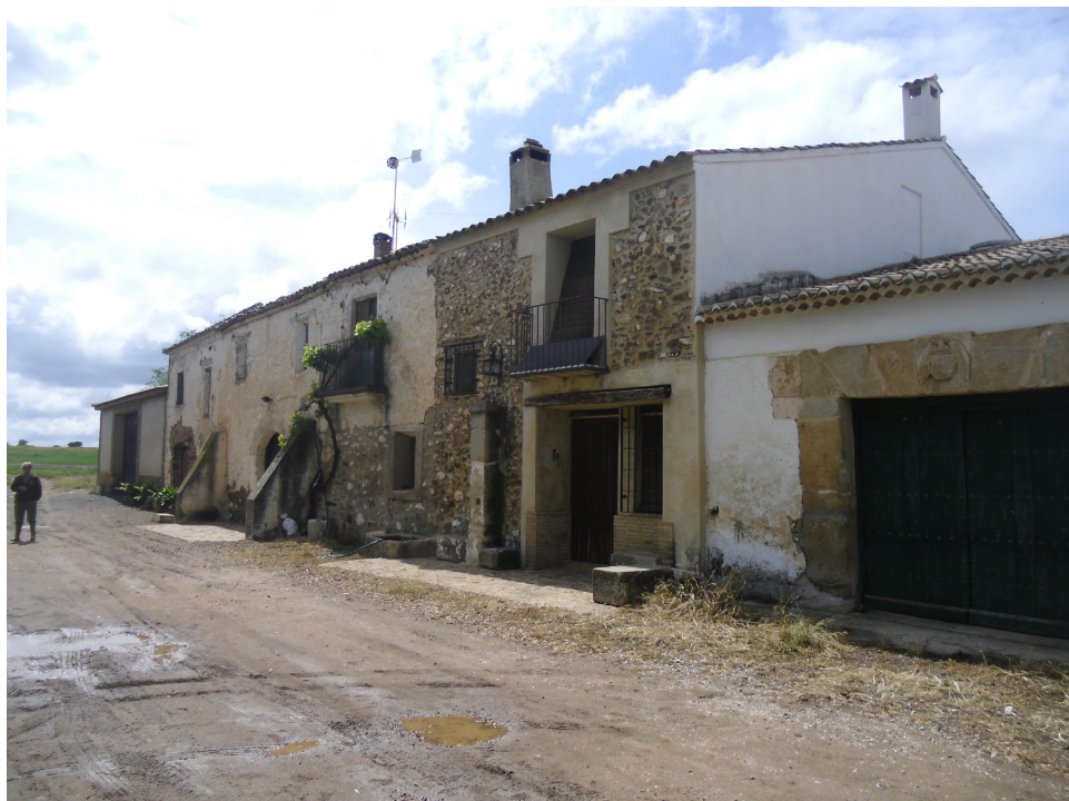
Fig. 2: Conjunto de edificaciones de Venta Nueva. Foto del autor.
