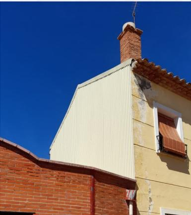
**CHAPA PARA EVITAR HUMEDAD SALA DE LOS ESPEJOS**
